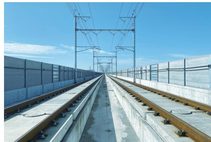
「北陸新幹線の金沢～敦賀延伸に伴い、小松鉄道軌道建設所担当範囲のうち、高崎起点355k562m～368k455m(延長12,892m明かり区間)におけるスラブ軌道及び電車留置線通路線分岐起点1k262m～1k826m(延長564m)のバラスト軌道を敷設する工事を行いました。
