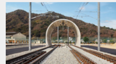
新幹線トンネル
